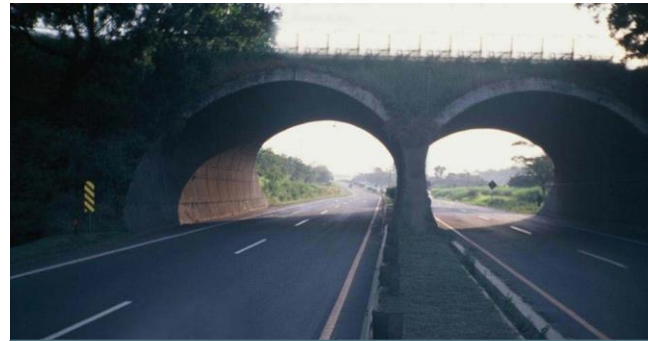
HPAS dengan Head Wall Beton Jalan Tol Semarang
