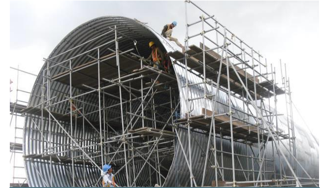
MPP Tambang PT ADARO – Kalimantan
