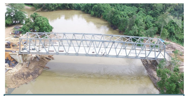
Jembatan Rangka A -99 meter Berau., KALTIM
