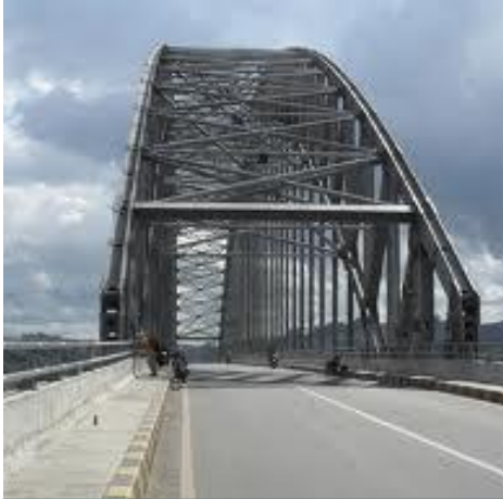
Jembatan Mahakam Ulu – Samarinda
